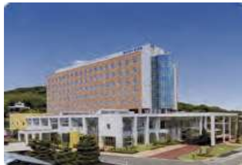
福岡新水巻病院・外観
